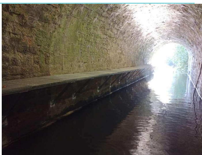
Figure 21 - passage à faune sous la RD 323 effectué par le CD 49 en 2021
