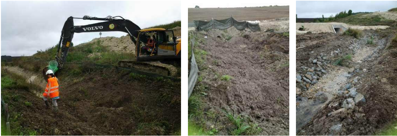
Figure 20 - Photos d'un exemple de griffage de cours d'eau avant destruction et de la réutilisation de la végétation sur le nouveau tracé - T Hercé
