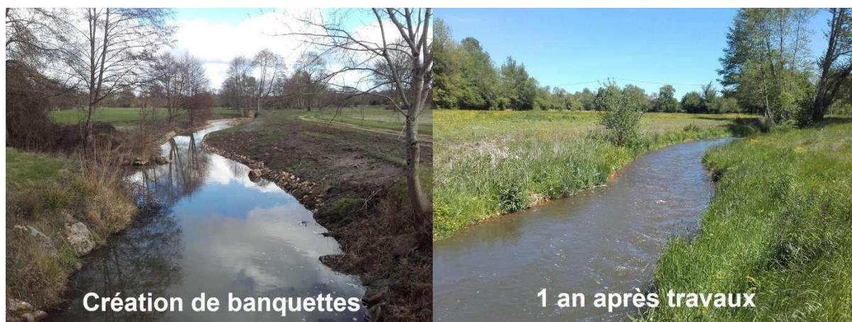
Figure 5-Création de banquettes sur le Lathan
